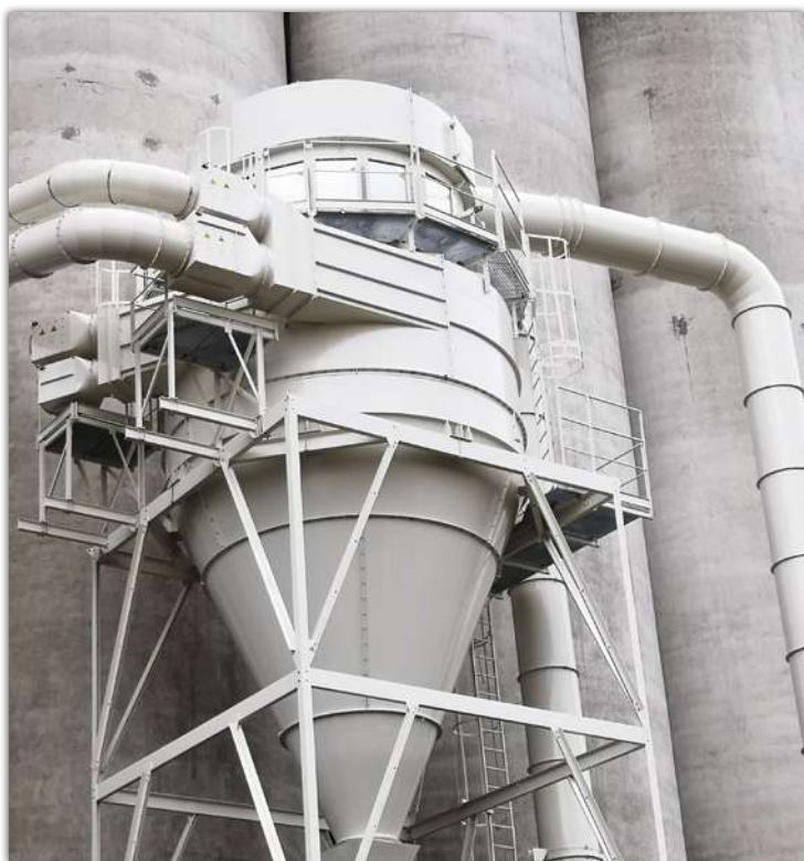
Cyclofiltre 4Y9 avec un débit d'air de 86 000 m 3 / h.
