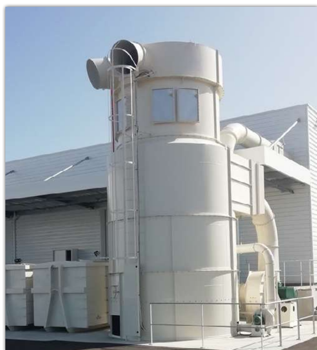
Cyclofiltre 4X7 avec débit d'air de 31 000 m 3 / h pour aspirer les poussières de bois sur quatre centres d'usinage.
