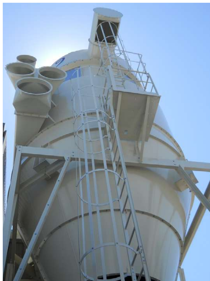
Cyclofiltre 4Y8 avec charpente et boîte entrée spéciale.
